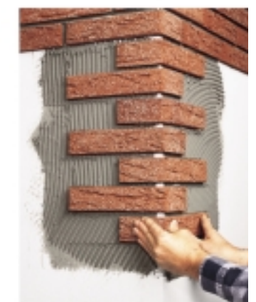
2. Il listelli angolari sono allineati nel letto di malta e ...
